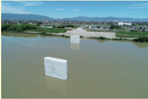
橋りょう整備事業 県道羽島稲沢線新濃尾大橋下部工事 (愛知県一宮市)
