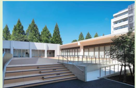
岐阜大学応用生物科学部校舎 (A・D棟) 改修工事 (岐阜県岐阜市)
