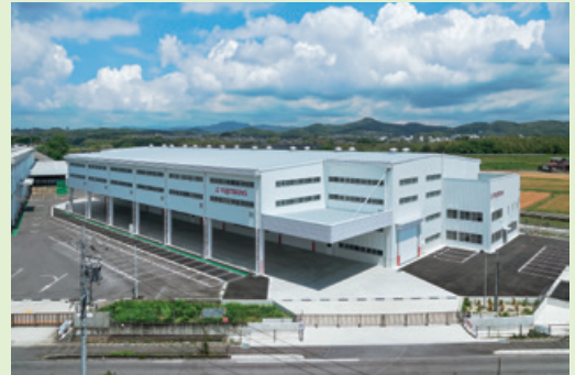
フジトランスコーポレーション 豊田物流センター2号倉庫新築工事 (愛知県豊田市)
