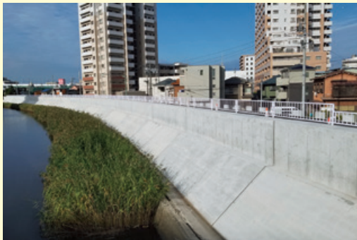
広域河川山崎川改修工事 (R1荒崎) (愛知県名古屋市長古屋市)
