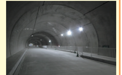
道路改良事業 一般国道301号松平トンネル (仮称) 建設工事 (愛知県豊田市)
