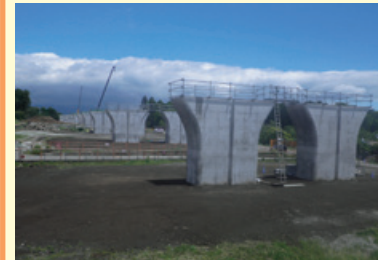
新東名高速道路 ぐみ沢下高架橋他1橋 (下部工) 工事 (静岡県御殿場市)
