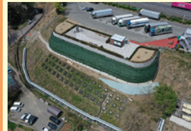
中央自動車道初狩パーキングエリア慰霊施設工事 (山梨県大月市)
