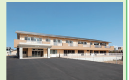
幼保連携型認定こども園 (仮称) 中条南こども園新築工事 (石川県河北郡)
