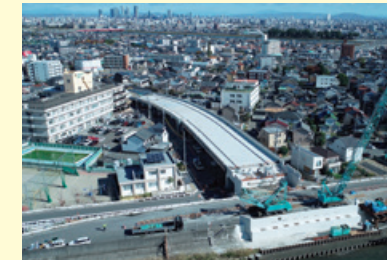
正江橋 (仮称) 築造工事 (左岸取付道PC上部工) (愛知県名古屋市)
