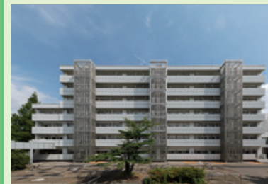
岐阜大学応用生物科学部校舎改修工事 (岐阜県岐阜市)
