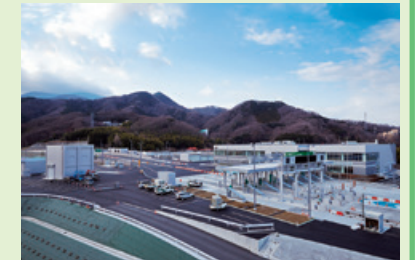
新東名高速道路 伊勢原JCT～伊勢原北IC間 管理施設新築工事 (神奈川県伊勢原市)
