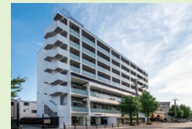
大阪港勤労福祉会館・港湾労働者住宅複合施設新築工事 (大阪府大阪市)
