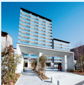
(仮称) 矢向プロジェクト新築工事（神奈川県川崎市）
