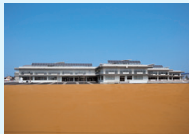
(新) 中藤小学校校舎新築工事（福井県福井市）
