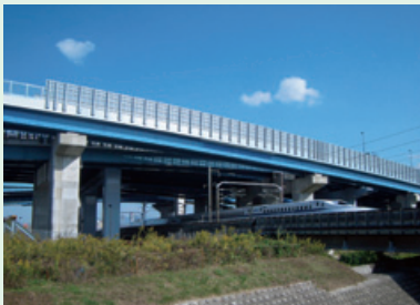
新幹線488K900付近大山崎Bo（Ⅰ期）新設（京都府大山崎町）
