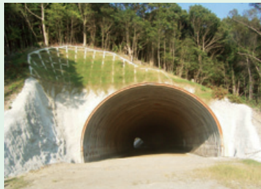
道路改良事業一般国道473号本宿トンネル（仮称）建設工事（愛知県岡崎市）
