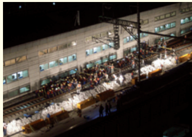
新大阪駅構内軌道新設ほか（2）（大阪府大阪市）
