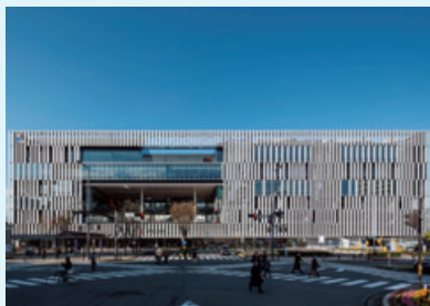
尾張一宮駅前ビル建設工事（愛知県一宮市）
