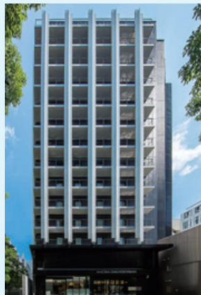
(仮称) 大阪淀屋橋プロジェクト新築工事 (大阪府大阪市)
