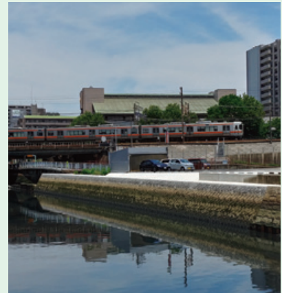
広域河川堀川改修工事 (29松重) (愛知県名古屋)
