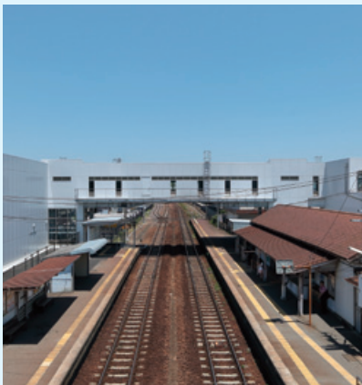
可児駅連絡通路新設ほか (岐阜県可児市)
