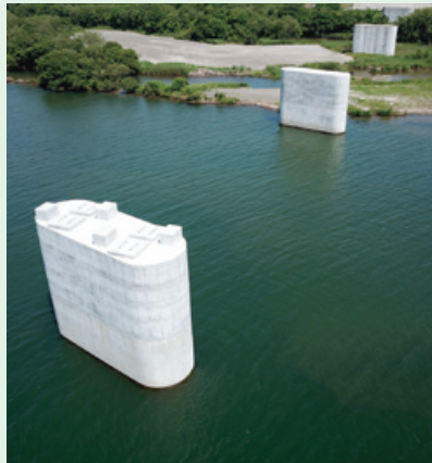
橋りょう整備事業 県道羽島稲沢線 新濃尾大橋 下部工事 (愛知県一宮市)
