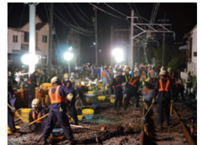
切換作業の様子
