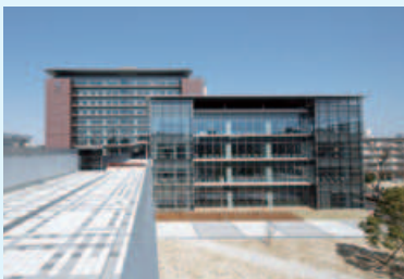
愛知学院大学名城公園キャンパス建設工事（愛知県名古屋市）
