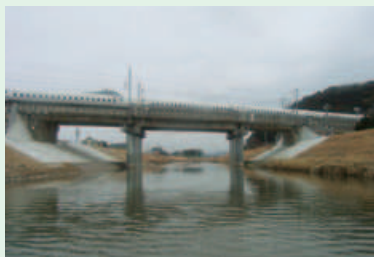
新幹線301K910付近第2広田川B防護ほか（愛知県西尾市）
