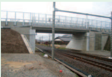
東海道本線一色Bo改築（滋賀県米原市）
