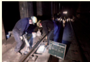
高速鉄道線路補修作業請負（名港保線区）（愛知県名古屋市）
