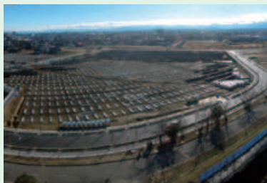
鈴鹿市南玉垣・白子地区23-基盤整備工事（三重県鈴鹿市）
