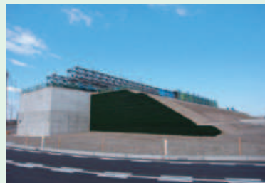
入善黒部バイパス 堀切（JR）跨線橋下部工事（富山県黒部市）
