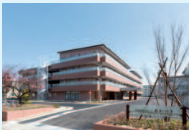
特別養護老人ホームあかつき新築工事（石川県金沢市）
