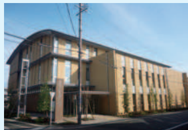
H25静岡地方方法務局藤枝出張所建築工事（静岡県藤枝市）
