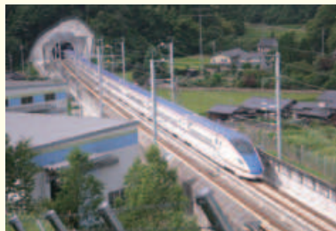
北陸新幹線、津幡軌道敷設 (石川県津幡町金沢市内)
