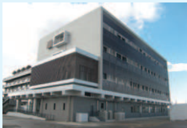
大治浄水場本館新築工事 (愛知県大治町)
