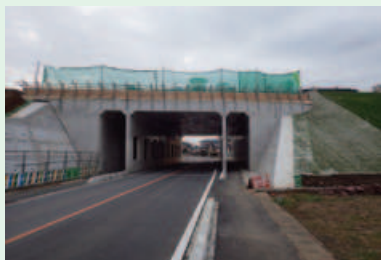
首都圏中央連絡自動車道 境地区整備工事 (茨城県境町)
