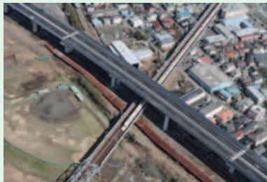
新幹線50K900付近さがみ縦貫道新設 (神奈川県寒川町)
