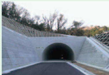
道路改良事業 県道東三河環状線牛川トンネル(仮称)建設工事 (愛知県豊橋市)
