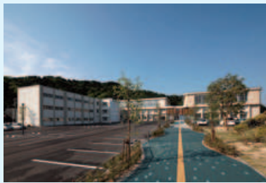
氷見市庁舎移転整備工事 (富山県氷見市)
