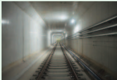
高速電気軌道第3・4号線車両回送用連絡線設置工事 (大阪府大阪市)
