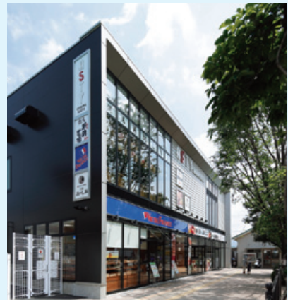
三島駅南口JSK新ビル建設工事 （静岡県三島市）
