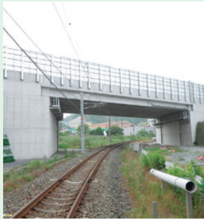
飯田線有海Bo新設 （愛知県新城市）
