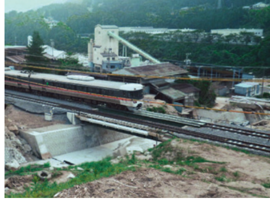
復旧工事完了
