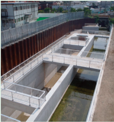
公共下水道第65工区 満田川ポンプ場整備工事（その1） （大阪府枚方市）
