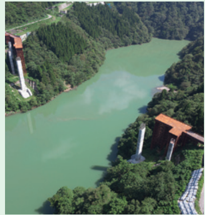
庄川橋梁下部（その4）工事 （富山県南砺市）
