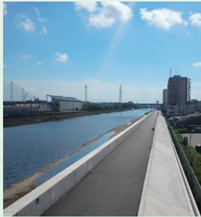
広域河川山崎川改修工事 (25道徳その2、26道徳その2) (愛知県名古屋市)
