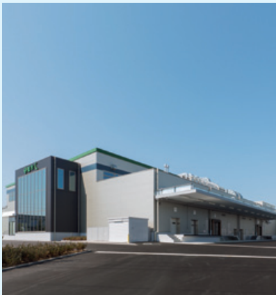
芝寿し いなほ工場新築工事 (石川県金沢市)
