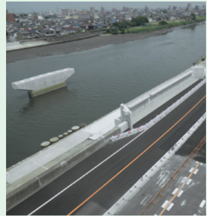
正江橋 (仮称) 築造工事 (下部工) (愛知県名古屋市)
