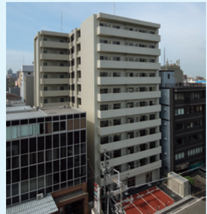
淀川工場跡地共同住宅建設工事 (大阪府大阪市)
