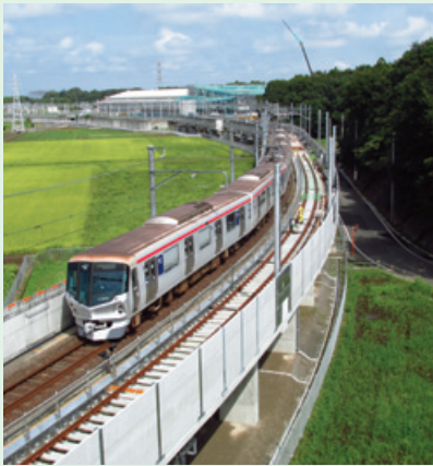
つくばエクスプレス線、車両基地出入庫線複線化 (茨城県守谷市他)
