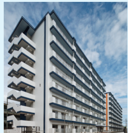
加島東住宅1号館建設工事 (大阪府大阪市)
