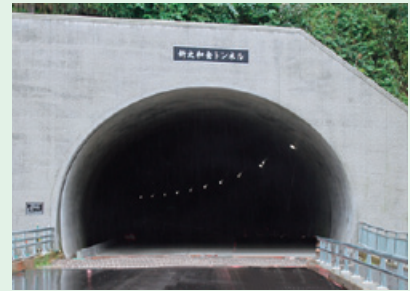
一般国道151号太和金トンネル(仮称)建設工事 (愛知県北設楽郡)
