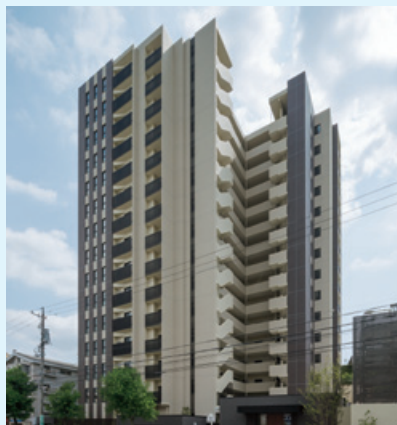
(仮称) 天白区八幡山計画 (施工) (愛知県名古屋)
