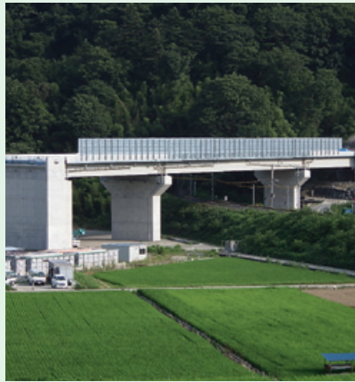
身延線宮原B〇新設 (山梨県西八代郡)
