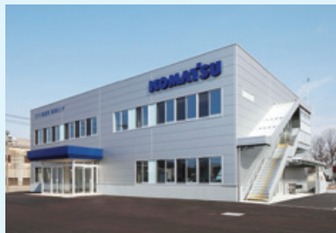
コマツ教習所栗津センタ新築工事 (石川県小松市)
