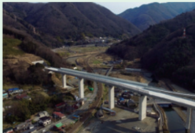
身延線常葉川Bo上部工新設 (山梨県南巨摩郡)
