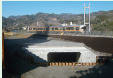
為栗・温田間102k090m付近架道橋新設工事 (長野県下伊那郡)
