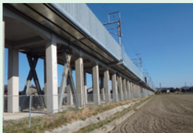
三河安城保線所管内土木構造物大規模改修 その他工事 (RC橋H28) (愛知県安城市)
