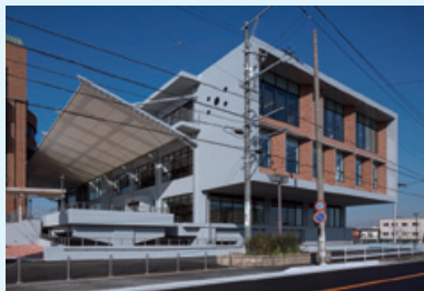
清須市本庁舎増築・改修工事 (愛知県清須市)
