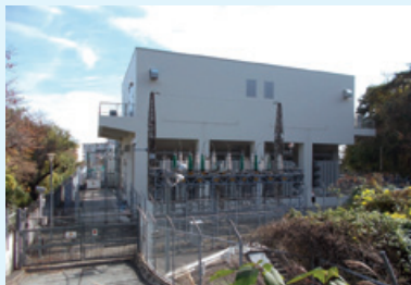
熱海変電所RPC棟新築その他工事 (静岡県熱海市)
