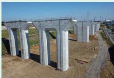
新東名高速道路 高森第二高架橋他3橋 (下部工) 工事 (神奈川県伊勢原市)
