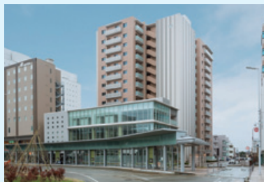
マストスクエア金沢新築工事 (石川県金沢市)
