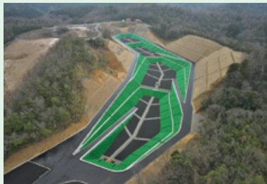
(仮称) 新規埋立処分場土木造成工事 (石川県羽咋市)
