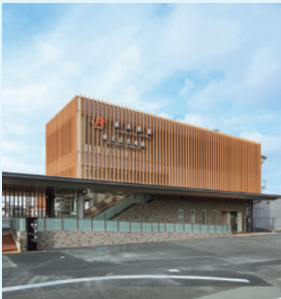
新所原駅改築 (静岡県湖西市)
