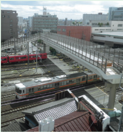
熱田構内御田B○新設ほか (愛知県名古屋市)
