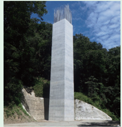
安威川ダム 左岸道路築造工事（生保工区H27） (大阪府茨木市)
