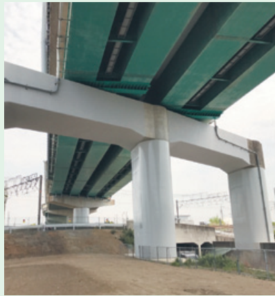
名古屋第二環状自動車道清洲高架橋他1橋耐震補強工事 (愛知県清須市)
