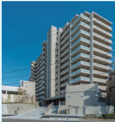
岡崎柱町社宅跡地計画（分譲マンション）設計・施工 (愛知県岡崎市)
