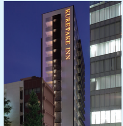
名古屋駅南ホテル開発新築工事 (愛知県名古屋市)
