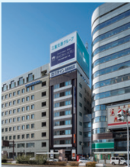
三交イン名古屋新幹線口ANNEX改修工事 (愛知県名古屋市)
