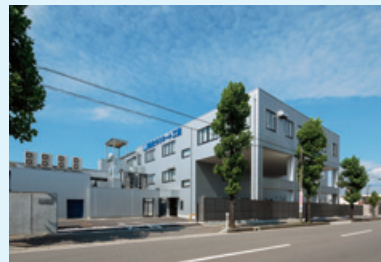
昭北ラミネート工業 (株) 本社工場フェニックス棟建設工事 (富山県富山市)
