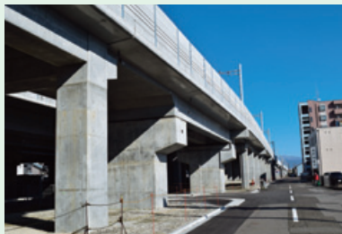
えちぜん鉄道、福井駅付近高架橋他 (福井県福井市)
