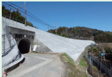
南荒尾・関ヶ原間418k000m付近のり改良工事 (岐阜県不破郡垂井町)
