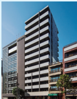
(仮称) 台東3丁目マンション新築工事 (東京都台東区)
