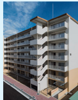
大阪市宮豊里第2住宅19号館建設工事 (大阪府大阪市)
