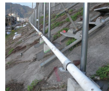
軌道盛土の影響計測 (盛土耐震補強工事)
