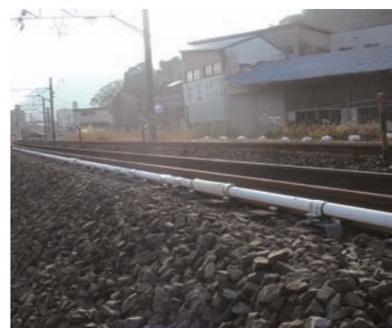
軌道の影響計測 (軌道越し推進工事)
