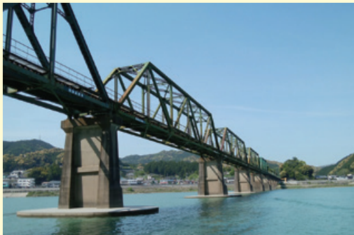
紀勢本線熊野川B橋脚基礎補強 (三重県紀宝町他)
