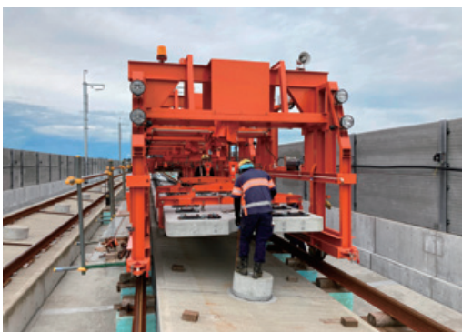
スラブ軌道敷設作業の様子
