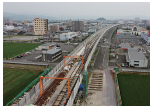
福井工区現場写真
