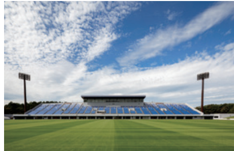
港サッカー場改修工事（CCUS活用推奨）
