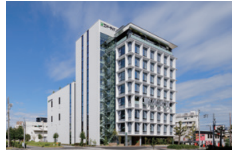
コンドーテック（株）大阪本社社屋及び倉庫新築工事
