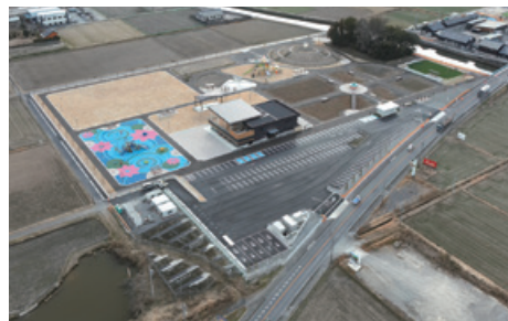
道の駅周辺整備工事（東ゾーン）
