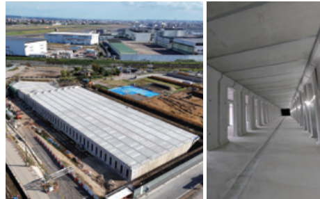
総合治水対策特定河川工事（大山川調節池本体1号工） （ICT指定・週休2日・環境整備・遠隔臨場）
