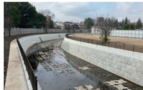
善福寺川整備工事
