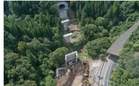
大野油坂道路道場切橋他下部他工事
