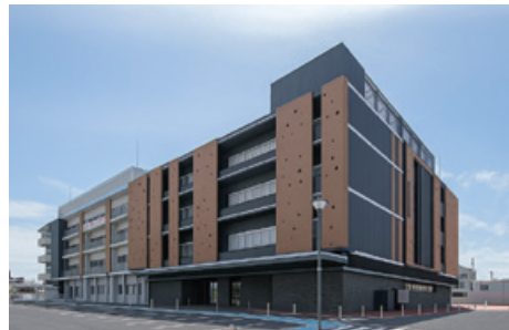
清須市役所庁舎増築・改築工事
