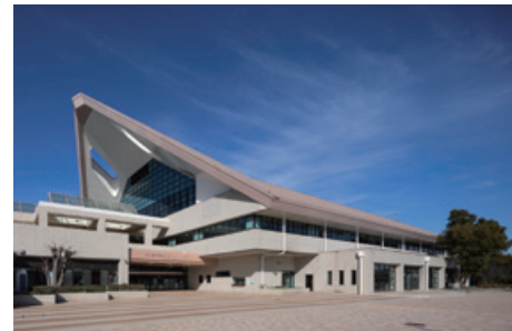
稲永スポーツセンター改修工事
