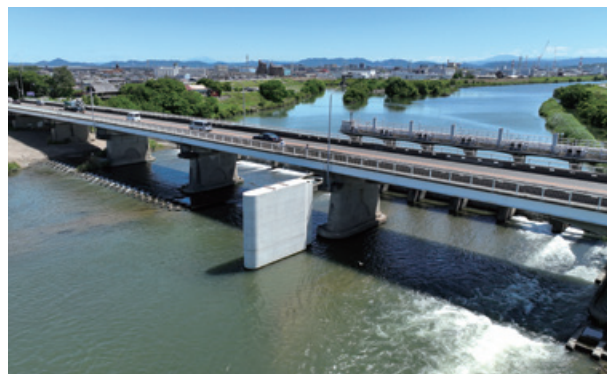
水分橋改築工事（下部工）ほか（愛知県名古屋市）
