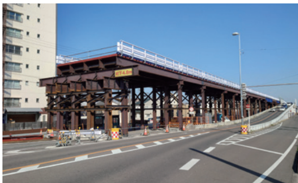
街路改良工事（愛知県清須市）
