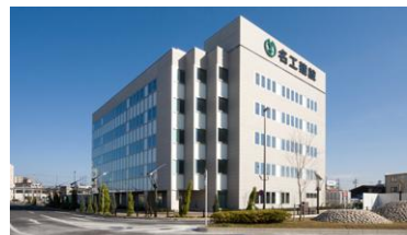
枇杷島社屋完成(2009年)
