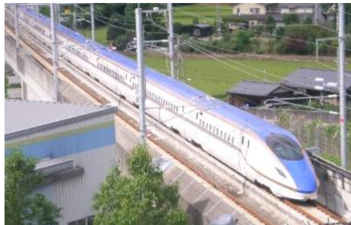
石川県津幡町 北陸新幹線 津幡軌道新設工事
