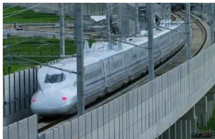
熊本県八代市 九州新幹線 八代軌道新設工事
