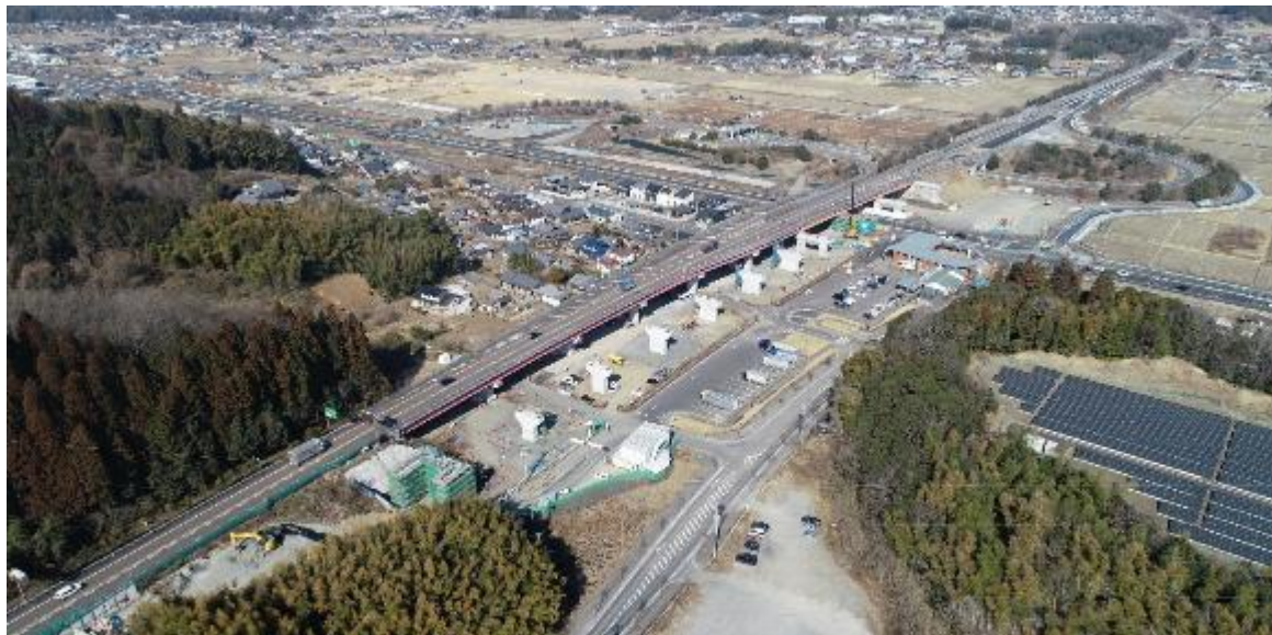
岐阜県可児市 東海環状自動車道 柿田高架橋(下部工)工事
