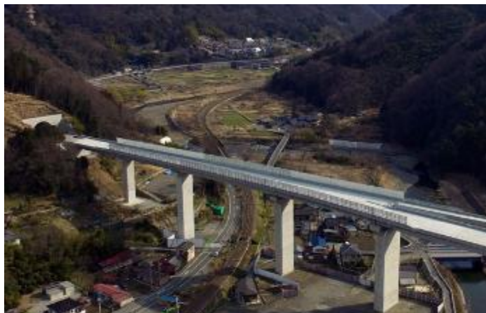
山梨県南巨摩郡 身延線 常葉川Bo上部工新設工事
