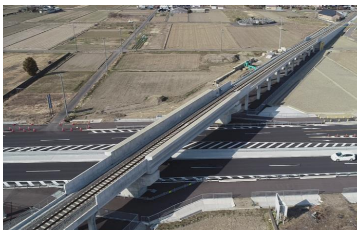
岐阜県本巣市 樽見鉄道 樽見線 単独立体交差工事
