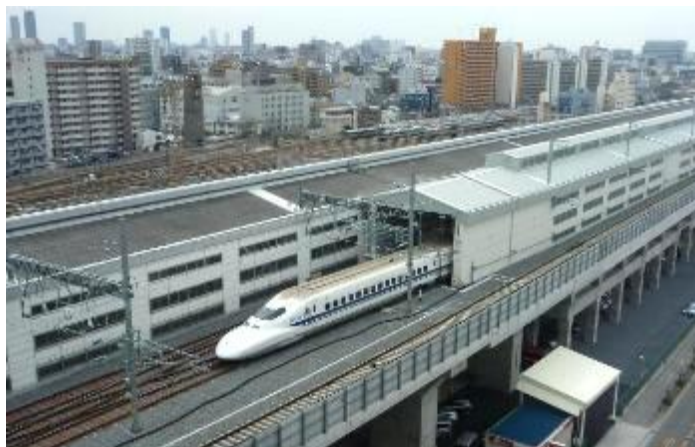
大阪府大阪市 新大阪駅構内 軌道新設工事
