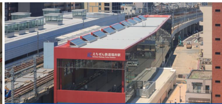
福井県福井市 えちぜん鉄道 福井駅他箇所新築
