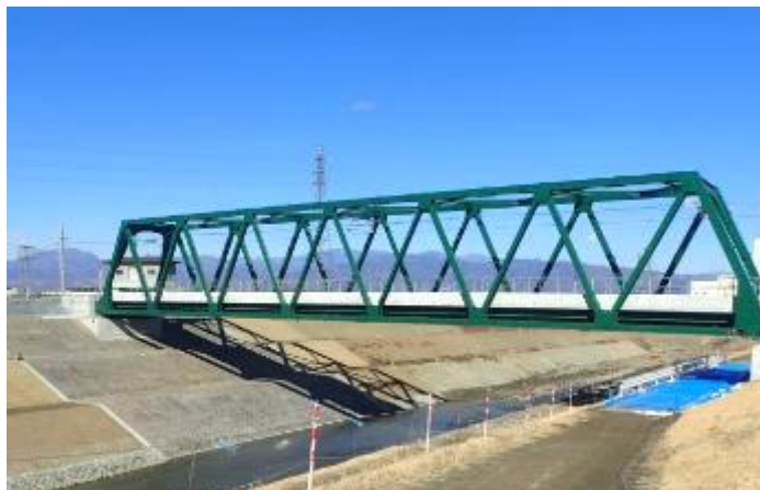
山梨県中央市 身延線 今川橋りょう改築工事
