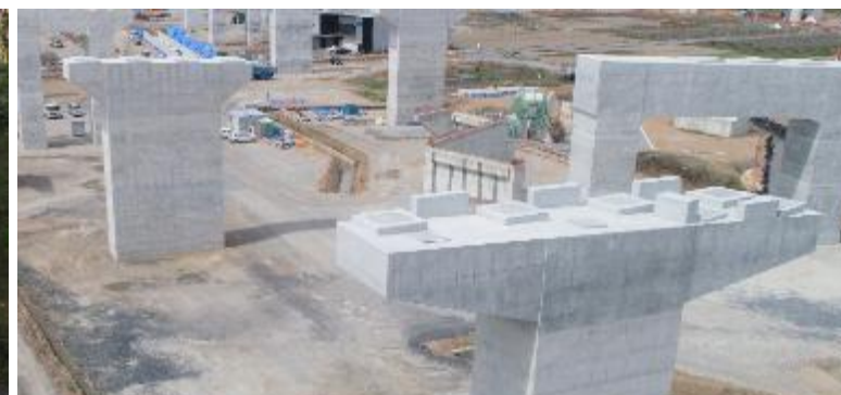
岐阜県岐阜市 岐阜IC 新設工事
