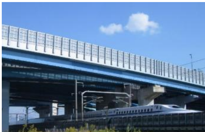
京都府乙訓郡 東海道新幹線 大山崎Bo新設工事
