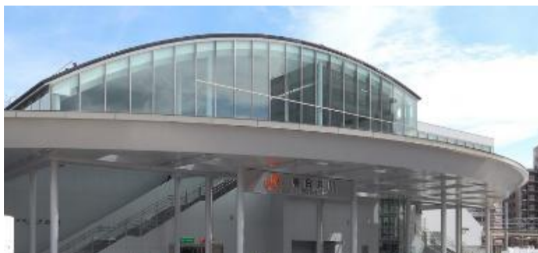
愛知県春日井市 春日井駅 改築工事
