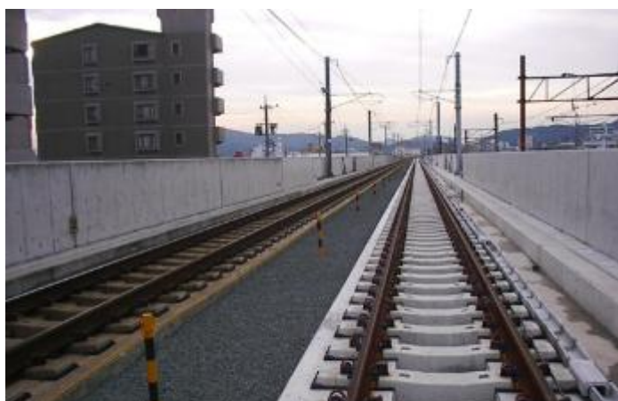
愛知県蒲郡市 東海道本線 蒲郡高架東工区
