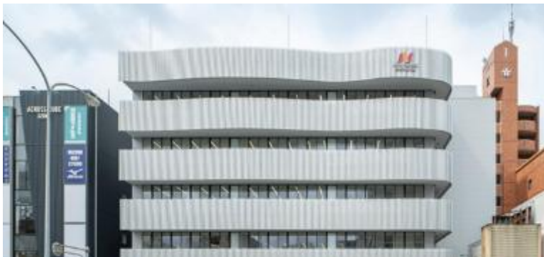
愛知県名古屋市 愛知県看護協会新研修会館新築工事
