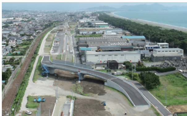
沼津貨物駅新設に伴う貨物通路こ線橋新設工事
