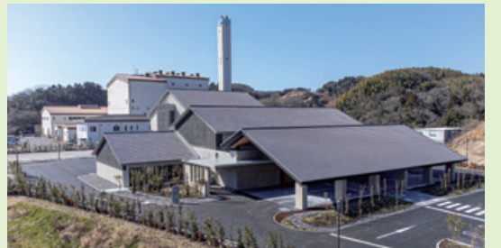
知多南部衛生組合火葬場建設工事 (愛知県知多郡)
