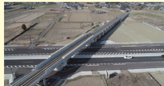
樽見鉄道 樽見線 美江寺駅～北方真桑駅間 (9km600m付近) 単独立体交差工事 (岐阜県本巣市)
