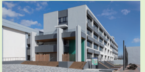
愛知教育大学 (井ヶ谷) 総合研究棟 (創造科学系) 改修工事 (愛知県刈谷市)
