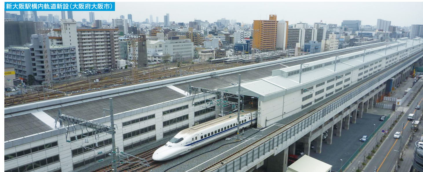
北陸新幹線津幡軌道新設(石川県津幡町)
