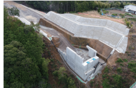
すさみ串本道路田子川橋A2橋台他工事
