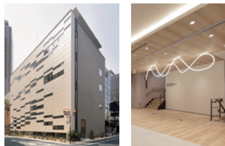
ニューロングリアクロストークセンター順天堂新築工事
