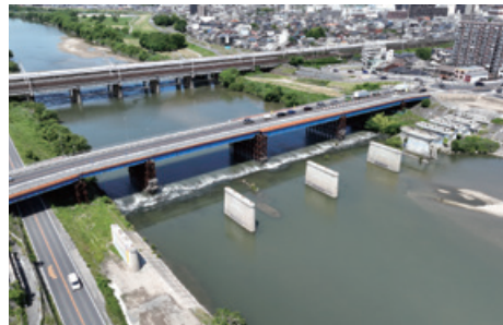
枇杷島橋改築工事（旧橋撤去）
