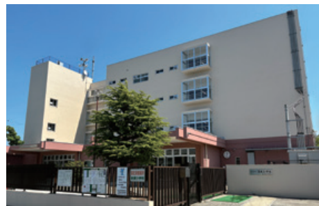
泉大津市立条東小学校校舎棟長寿命化改良工事
