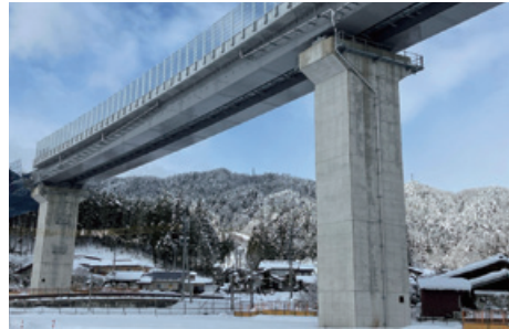
高山本線下切Bo新設
