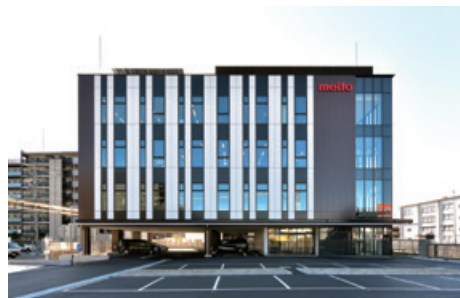
(仮称) 名糖産業 本社ビル新築工事
