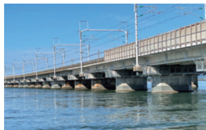
新幹線253K134付近第三浜名橋梁ほか2橋 橋脚修繕ほか(5) (静岡県湖西市)
