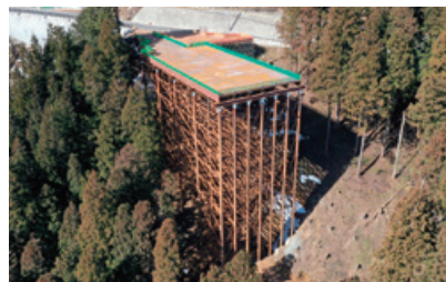
足羽川ダム付替県道4号橋A2橋台仮栈橋設置他工事 (福井県今立郡)
