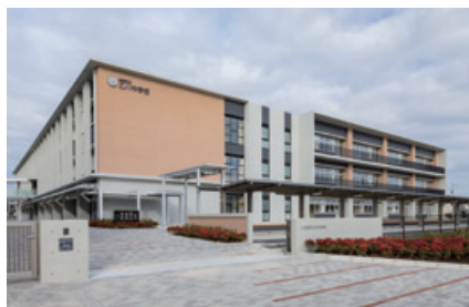
乙川中学校改築工事（愛知県半田市）
