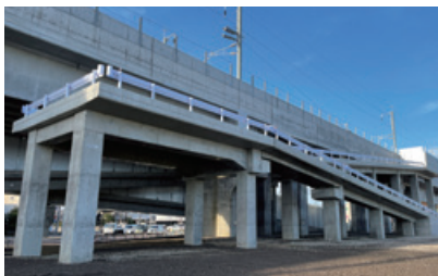
北陸新幹線、開発保守用斜路 (福井県福井市)
