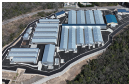
畜産総合センター種鶏場整備建設工事（愛知県小牧市）
