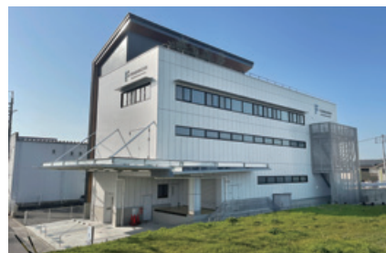
船橋株式会社 中川工場新築工事（愛知県名古屋）
