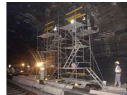
鉄道トンネル裏込注入施工状況
