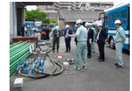
高強度配合グラウト材・材料試験 圧送距離1km、18 N/mm 2
