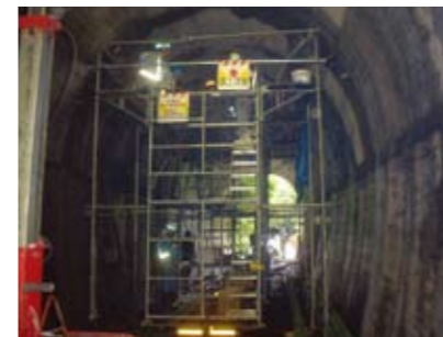
廃線トンネルを利用した現地試験状況 配管延長3km
