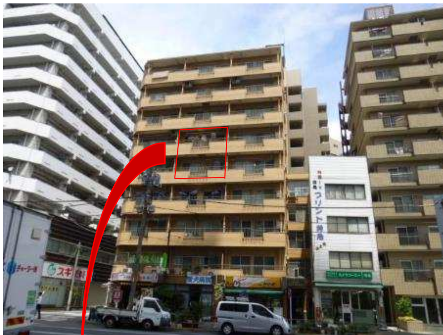
集合住宅SMIC部材設置前の建物外観
