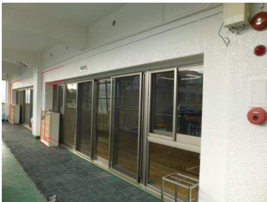
SMIC部材設置後・仕上げ完了
