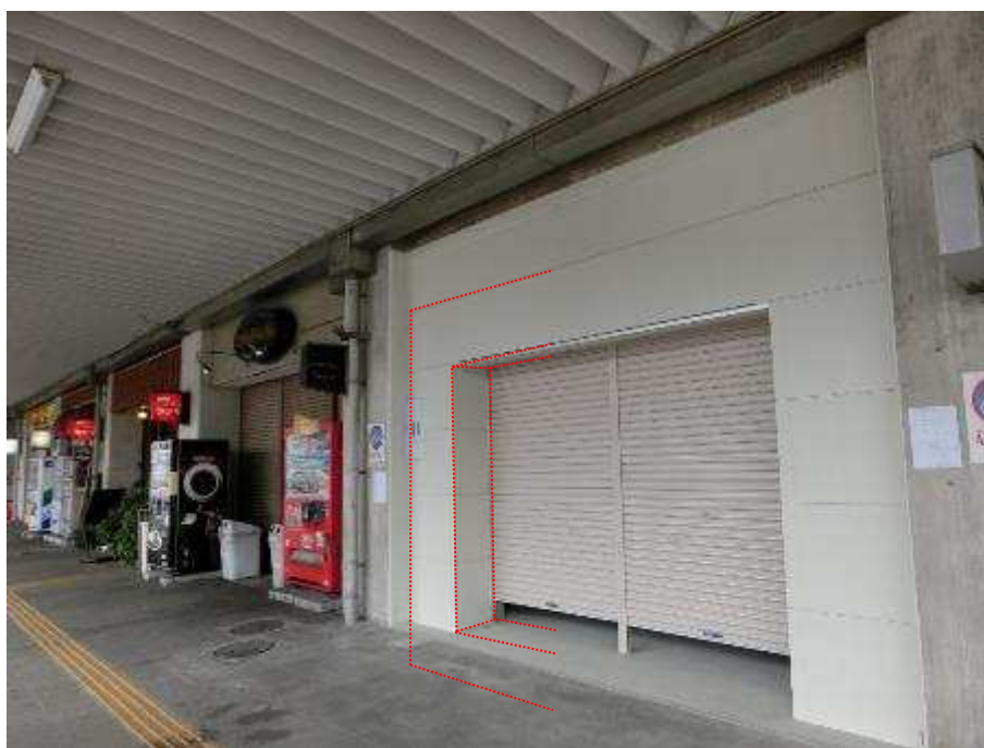
口型 W=4,600 H=4,300 b = 350 上弦材D=580 下弦材D=350
